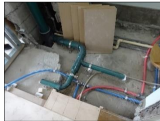
給排水内装改修工事（中区）
