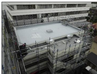
大規模修繕工事（金沢区）
