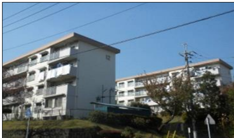
桜台団地（青葉区）施工前
