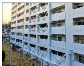
リフォーム事業 ぐみさわ東ハイツ (戸塚区) 耐震補強工事
