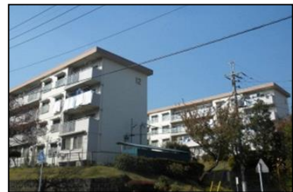
桜台団地 (青葉区) 現況
