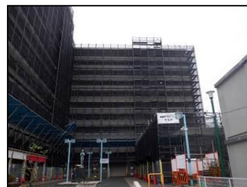
大規模修繕工事
