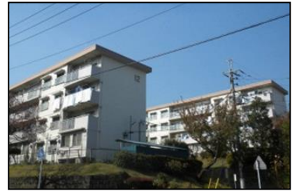
桜台団地 (青葉区) 現況
