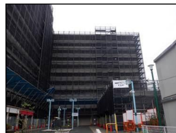
大規模修繕工事
