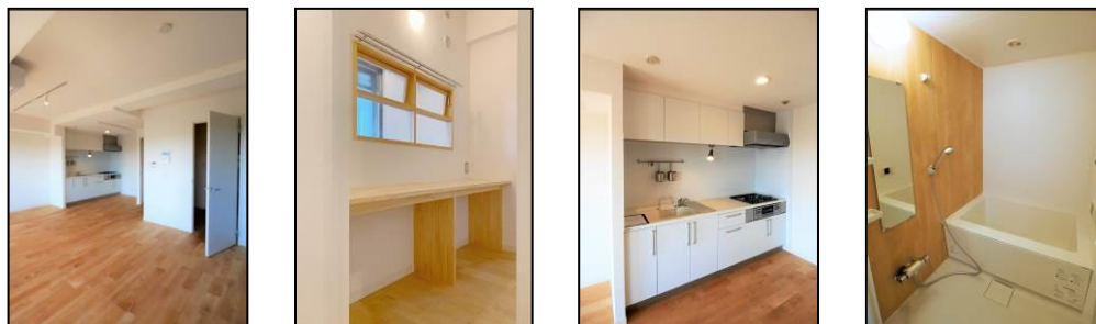
オクトス市ケ尾（青葉区）カスタマイズ賃貸住戸 間取り変更、ワークスペース確保、キッチン・浴室リニューアル工事を実施
