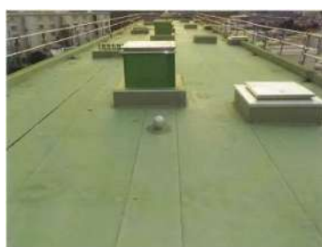
屋上防水工事 改修前 十日市場ヒルタウン（緑区）
