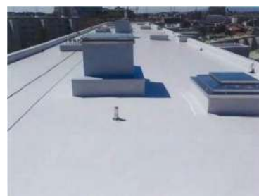
屋上防水工事 改修後 十日市場ヒルタウン（緑区）
