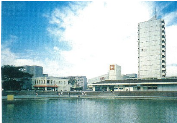
「センターシーサイド金沢」(金沢区)
