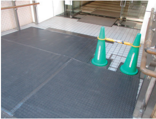
○エントランス(修繕前)
