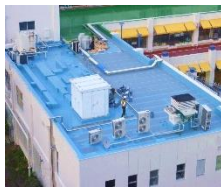
改修工事実施物件
