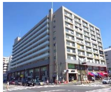
根岸駅前ビル
