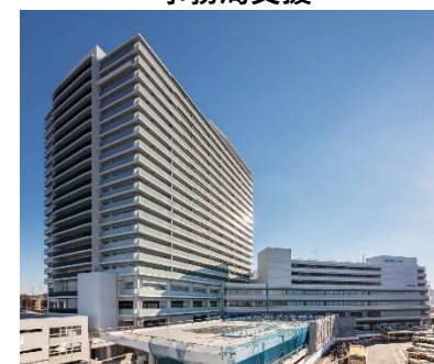
施設建築物の竣工
