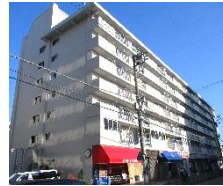
根岸駅前第二ビル
