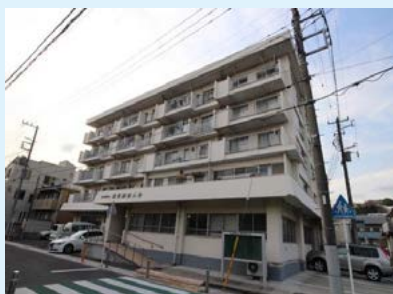
下之前住宅現況
