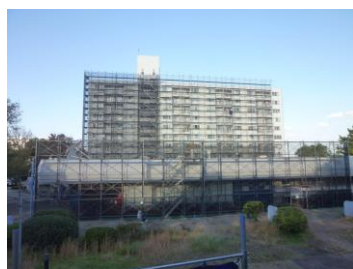
大規模修繕工事（外壁、屋上防水他）・工事監理 野庭団地第一住宅（港南区）
