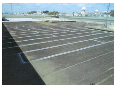
屋上防水工事 改修前 日吉本町ハイツ（港北区）
