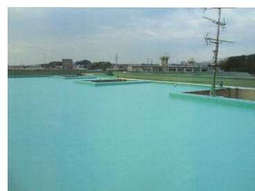
屋上防水工事 改修後 日吉本町ハイツ（港北区）
