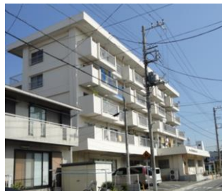
（仮称） 井土ヶ谷マンション（南区） 現況
