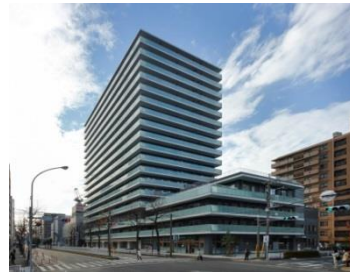
花咲町 6 丁目地区プロジェクト (西区) [横浜 MID ベースタワーレジデンス] 完成写真
