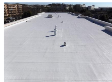
屋上防水工事 改修後 今宿ハイツ（旭区）
