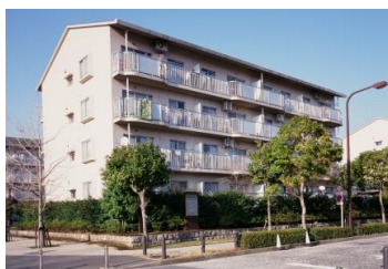
シーブリーズ金沢（金沢区）
