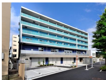
高優賃 飯塚磯子ビル 竣工写真 (磯子区)
