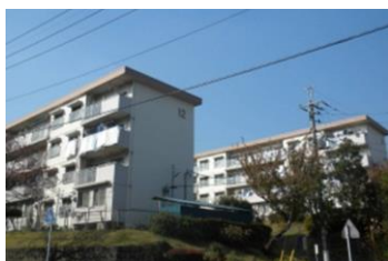
桜台団地（青葉区） 現況
