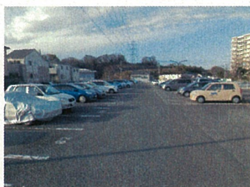
アスファルト舗装工事 改修前
