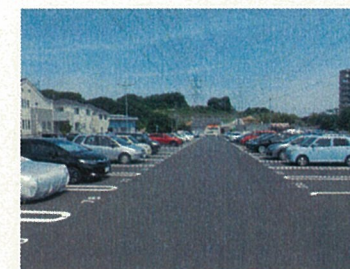
アスファルト舗装工事 改修後
