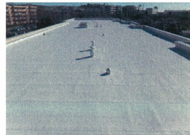
屋上防水工事 改修後 今宿ハイツ（旭区）
