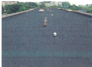
屋上防水工事 改修前 今宿ハイツ（旭区）
