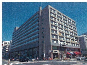
外壁塗装工事 改修後 根岸駅前ビル（磯子区）
