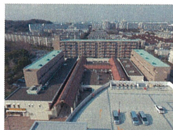
外壁塗装工事 改修後 さざなみ団地第二店舗併用住宅（金沢区）
