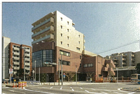
保土ヶ谷駅東口駅前地区
