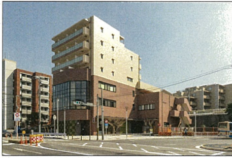
保土ヶ谷駅東口駅前地区
