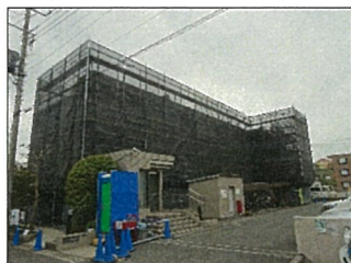
リフォーム事業 サニーハウス松風 (金沢区) 大規模修繕工事
