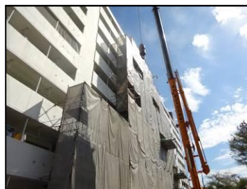
耐震改修工事（戸塚区）
