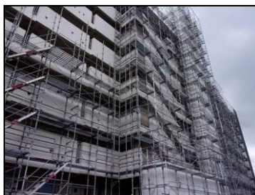
大規模修繕工事（中区）
