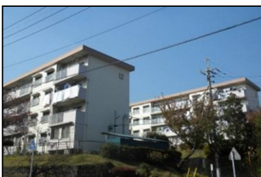
桜台団地（青葉区） 施工前
