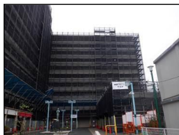
大規模修繕工事（港南区）
