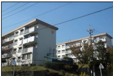
桜台団地（青葉区） 現況
