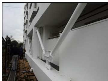
耐震改修工事（戸塚区）
