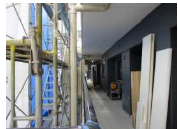
共用部施工中
