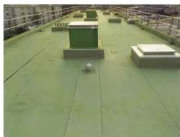
屋上防水工事 改修前 十日市場ヒルタウン（緑区）
