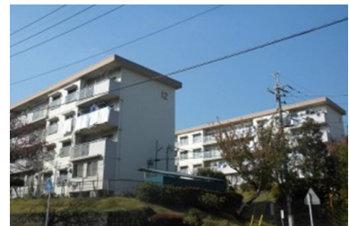
桜台団地（青葉区） 現況
